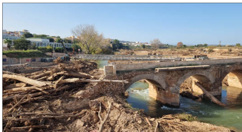
Uno de los puentes sobre el río Turia destruidos tras la riada del 29 de octubre por la DANA en Ribarroja. EE
